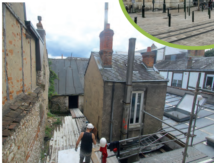
Travaux des îlots rue des Carmes.
