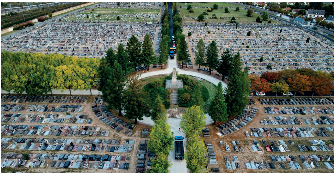
Travaux de chaussée du grand cimetière d'Orléans.
