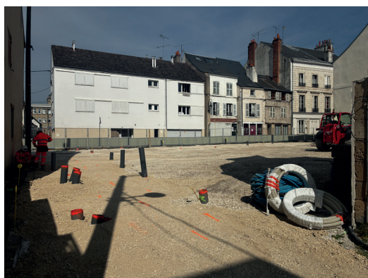
1 ère phase : préparation de la plateforme
