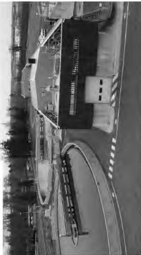
Les 3 clariflocculateurs de la STEP de la Source sont destinés à séparer l'eau des boues ou des résidus secondaires issus de la dégradation des matières organiques qui se déposent au fond des bassins.
