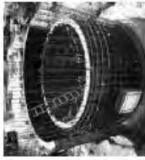
La Chapelle-Saint-Martin, chemin de Roumeaux Travaux de création d'un poste de refoulement
