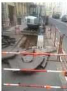
Des ouvertures de tranchées sur voirie neuve
