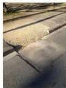
Des reprises non faites ou non réalisées dans les règles de l'art
